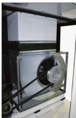
برای جلوگیری از انتقال لرزش فن و الکتروموتور به قسمتهای دیگر دستگاه و ساختهای از کانال قابل انعطاف جهت اتمام دهانه فن به کانال استفاده می‌شود و برای تعليق فن و الکتروموتور از شش عدد لرزه‌گیر لاستیک استفاده می‌شود تا لرزش کاملاً ازوله شود. انواع دیگر فنها مانند فنوهای سانتریفیوز با تیغه‌های اختباعقب و الکتروموتور از مارکهای دیگر در صورت سفارش قابل استفاده می‌باشد.
